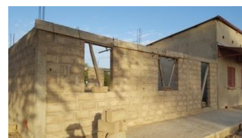
3 ème classe en construction
