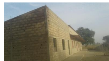
La construction aujourd'hui.
